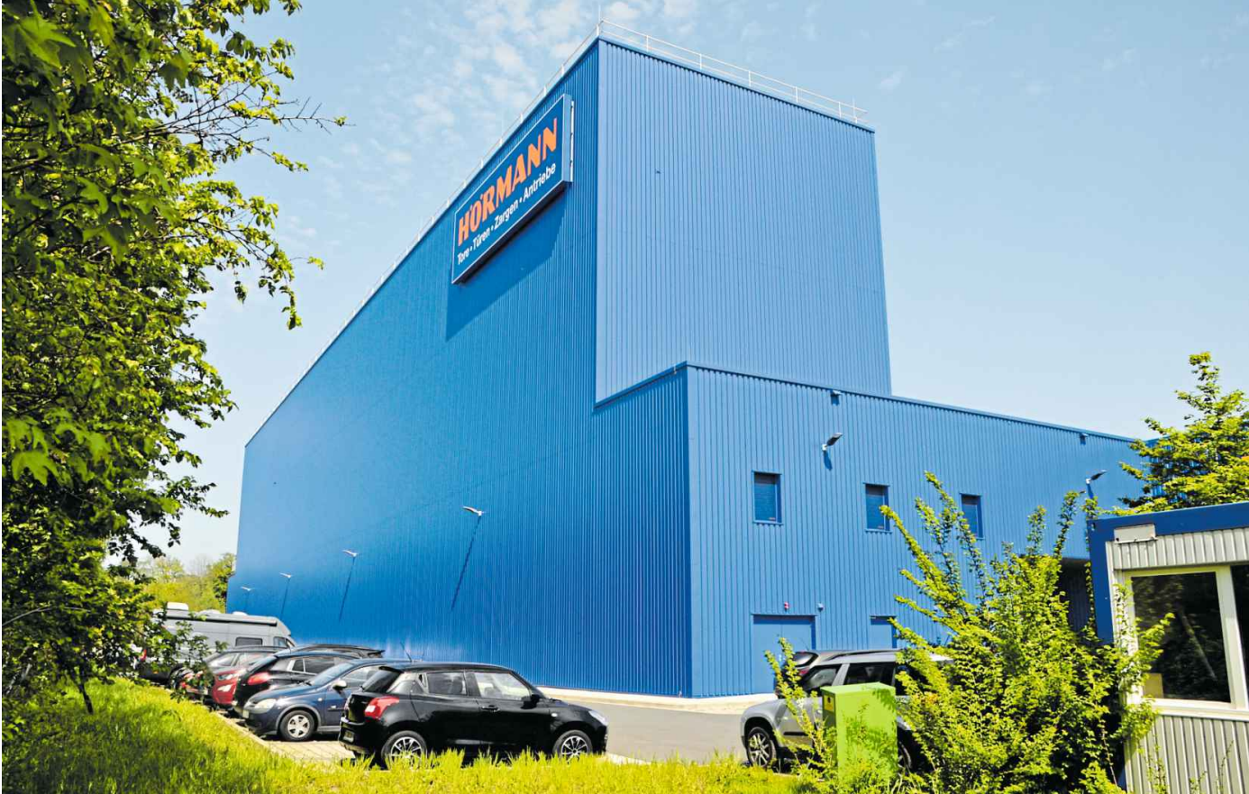
Ganz schön blau: Das neue Hochregallager von Hörmann am Sitz des Unternehmens an der Gütersloher Straße in Steinhausen-Brockhagen. Foto: Frank Jasper
