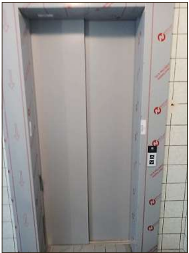
Am Aufzug wurde gearbeitet, aber er läuft laut Mieter immer noch nicht. Foto: privat
